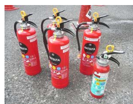
消火器の本数・配置場所 使用有効期限を確認
