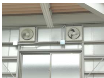
人感センサーで自稼動 する倉庫内換気扇
