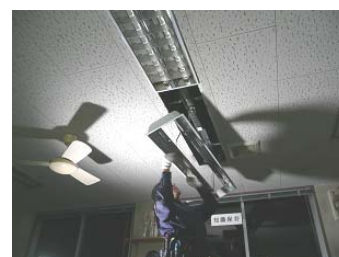
高効率蛍光灯への交換
