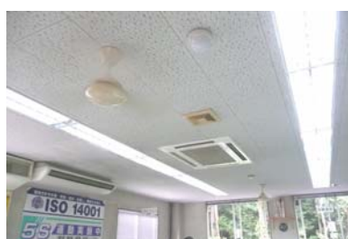
空調温度の適性化・効率化を 図るためのサーキュレータ
