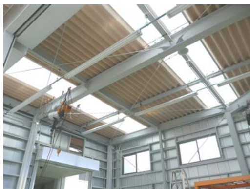
製品倉庫に採用した採光屋根 定期的に清掃を行い、昼間の省電を図っています
