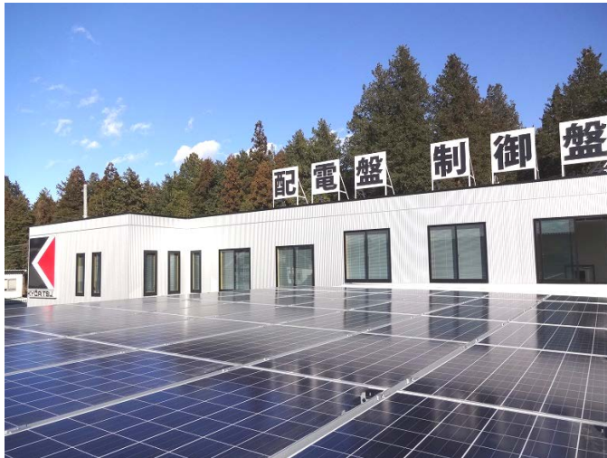
製品倉庫屋上に設置した太陽光発電システムのパネル
